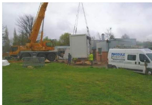
Arrivée et installation des modules
